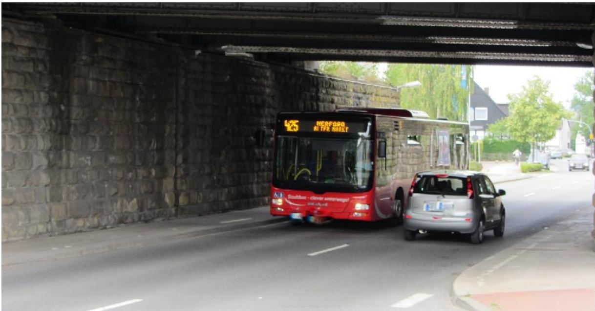
*Abbildung 2 Bahnunterführung Herforder Straße / Kölner Bahn – fehlender Abstand breiter Fahrzeuge zu Gehwegen*
